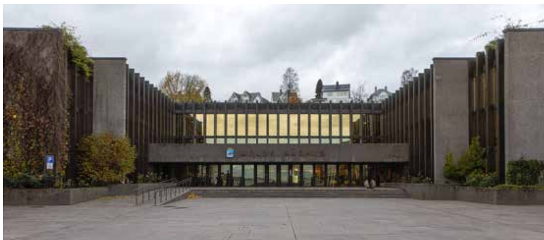
Rådhuset åpnet i 1966, med tidstypisk naturbetong og forgylt vindusglass. (Foto: Johnny Bratseth.)
